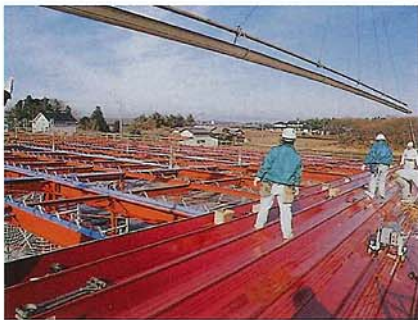
レッカーによる荷揚
